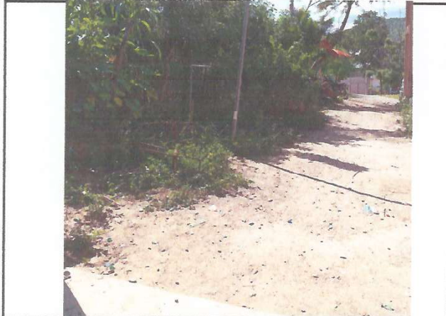
Foto 1: Mejoramiento con estructura tipo pórtico y lamina troquelada calibre 26 en la cocina.
